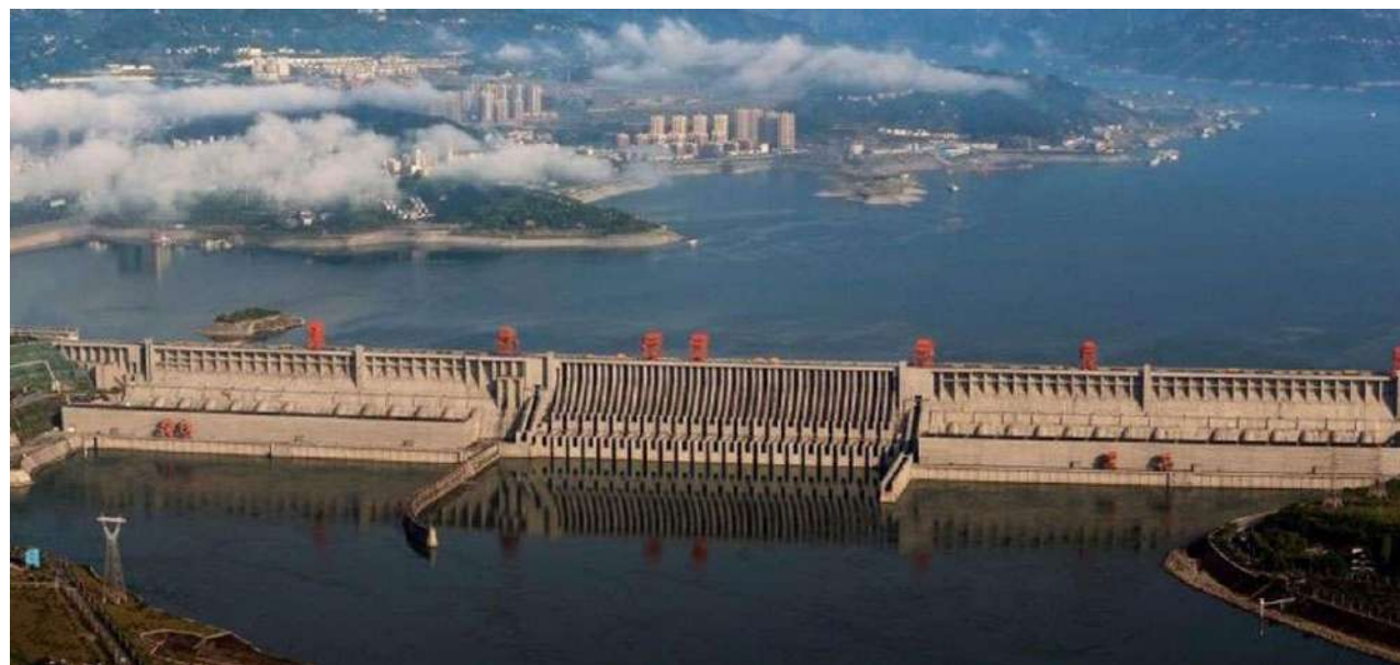
Diga sul Fiume Azzurro (Diga delle Tre Gole), Cina
