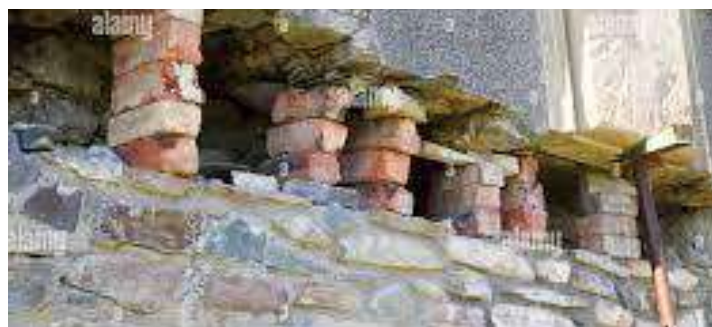
un modo per intendere la fragilità dell'edificio
