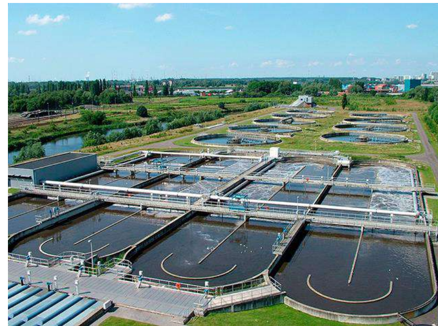
Impianti di Potabilizzazione
